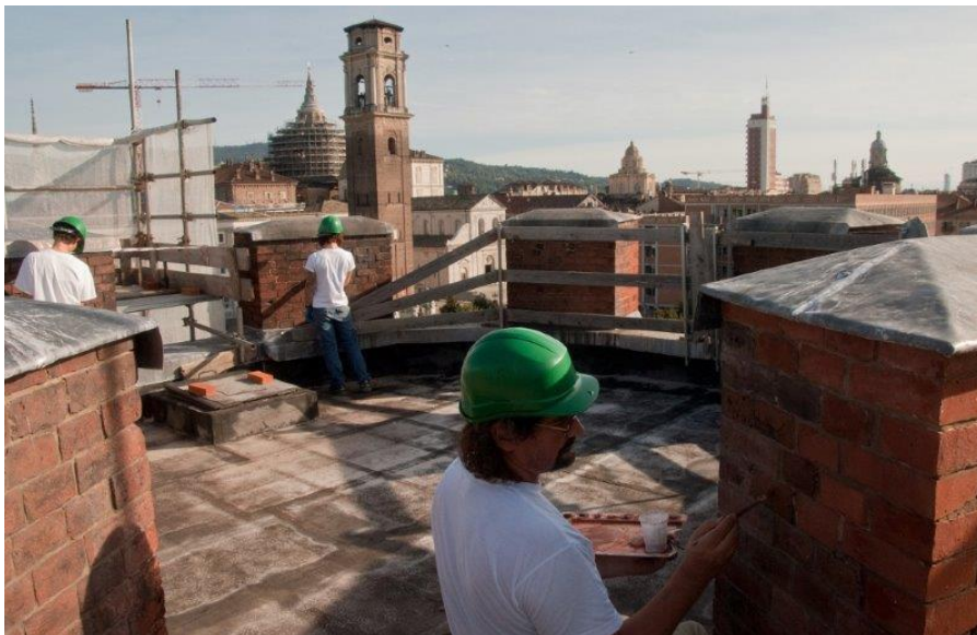
Lavori di restauro durante il cantiere del Consorzio San Luca concluso a dicembre 2014
